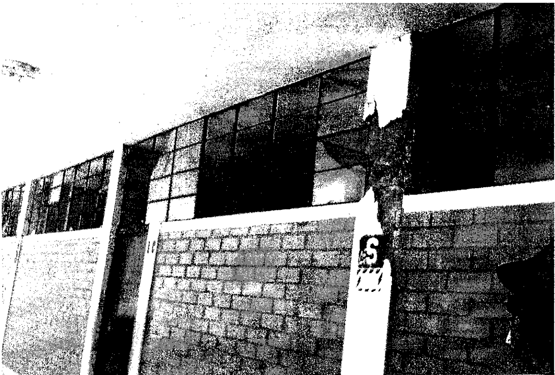
FOTO N° 2.- FALLA EN COLUMNAS
