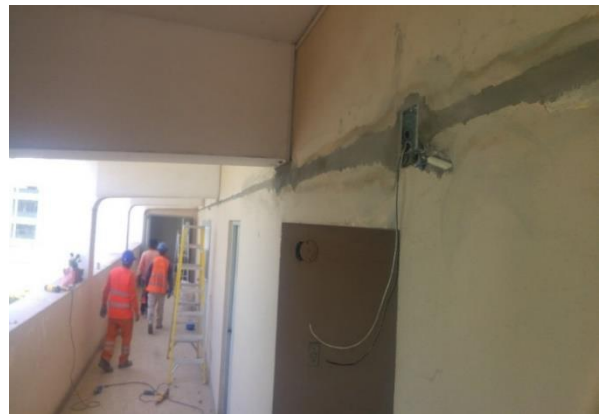
Instalación de luces de emergencia
