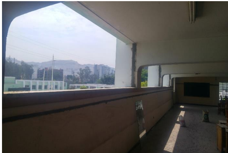
Cambio de ventanas
