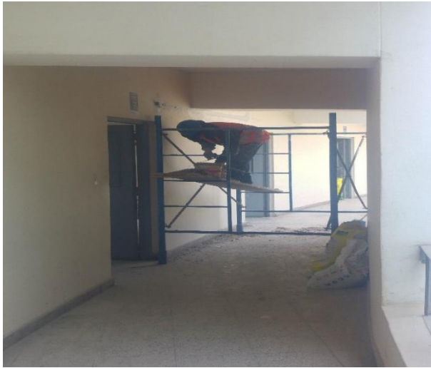
Pintado de aulas
